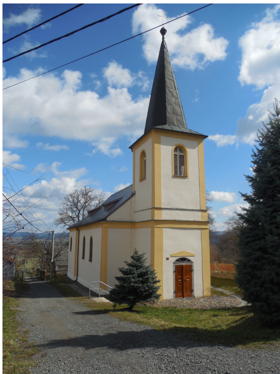
kaple svatého Jana Nepomuckého v Mileticích
