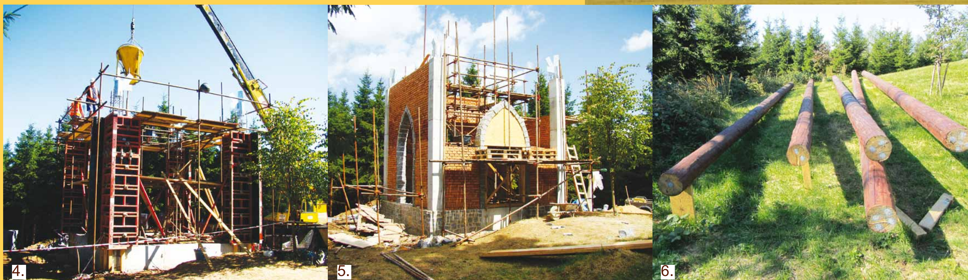
4., 5. - stavba spodní zděné vstupní části, 6. - hlavní dřevěné sloupy
